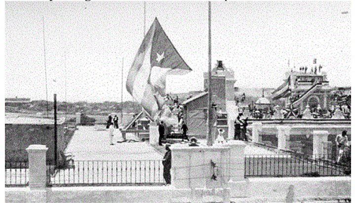
La bandera de Cuba ondea por primera vez en la azotea del antiguo Palacio de los Capitanes Generales, 20 de mayo, 1902.
